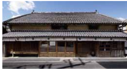
● 古民家を改修したホテルNIPPONIA (ONAE棟)の外観
